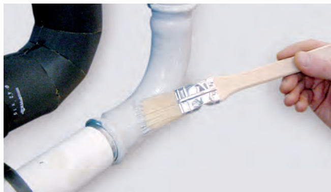
Obrázek 42 – Lakování přípojek a trubek základním nátěrem.
