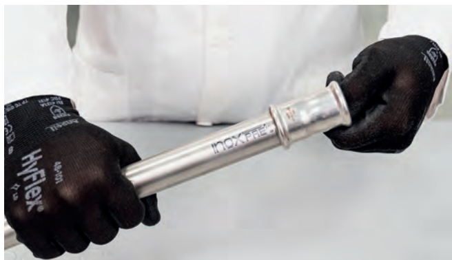
Obrázek 36 – Vložení trubky do lisovací tvarovky
