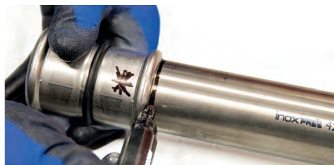
Obrázek 32 – Označení hloubky zasunutí s použitím tvarovky
