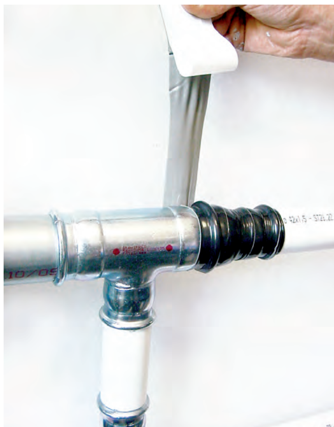
Obrázek 43 – Ochrana spojů butanolovou lepicí páskou
