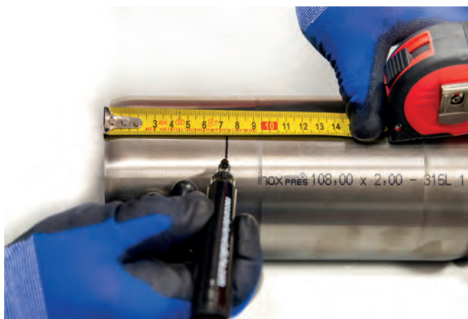
Obrázek 28 – Označení hloubky zasunutí s použitím svinovacího metru
